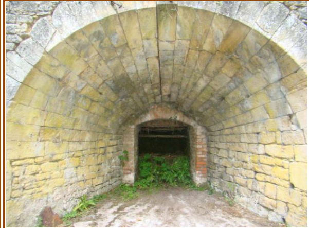
Le foyer du haut-fourneau
