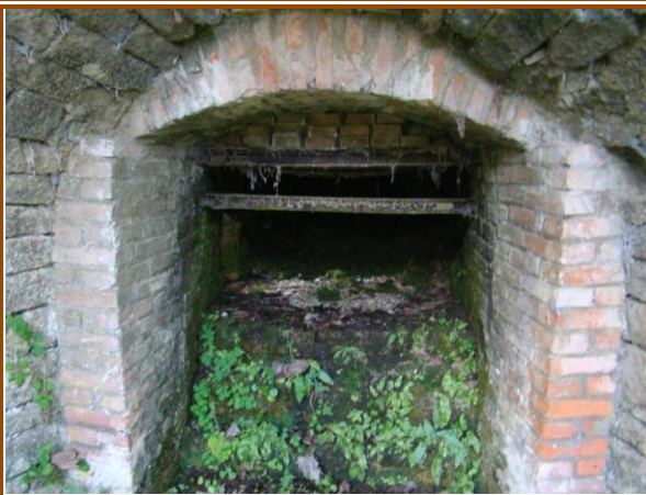
Foyer où l'on recueillait la fonte en fusion
