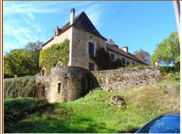
Maison du Maître des Forges (tours médiévales)
